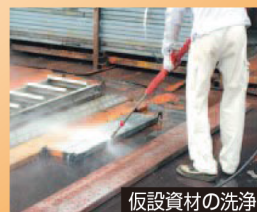
仮設資材の洗浄
